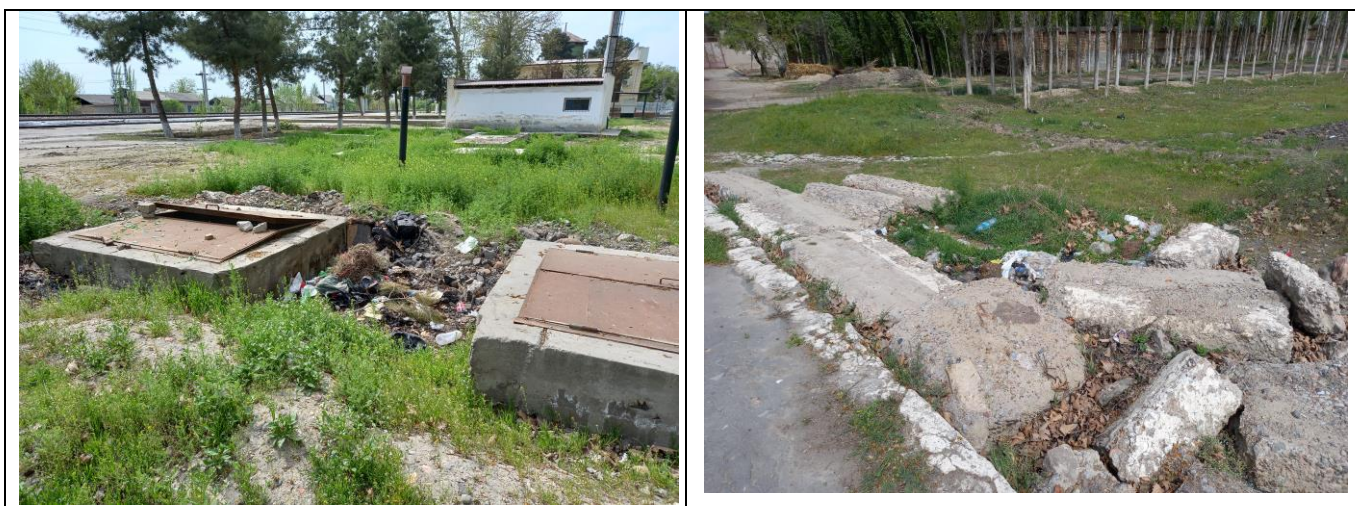
Рисунок 2. Загрязнение территории на станции Чуст.
