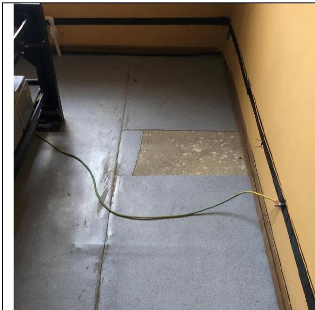
**Рисунок 6.** Заземление напольных устройств на станции «Наманган» не соответствует нормам (2022).
