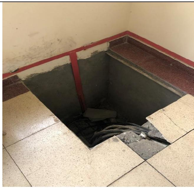
**Рисунок 7.** Отсутствует покрытие пола, что приводит к нарушению безопасности персонала на станции «Наманган» (2022).
